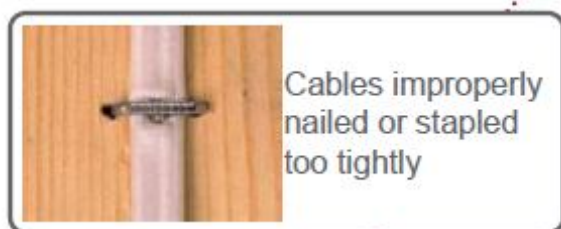
图 6：将金属紧固钉用力压在电线上产生并弧
